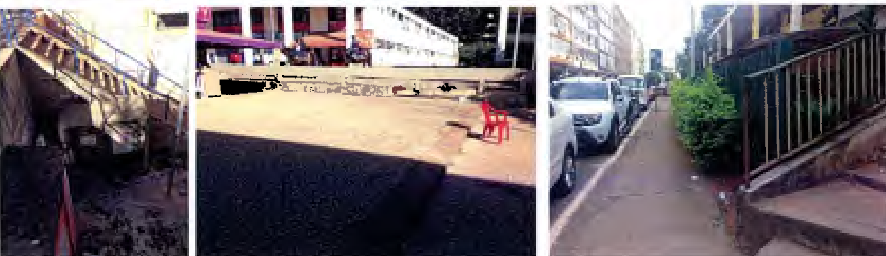
85 Figura 1- Situações encontradas na quadra 5 que demonstram o estado abando e degradação de espaços públicos
