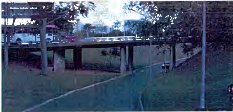
Figura 10 - Via N3 – Viaduto existente sob a faixa norte-sul da Via L2 Norte. Fonte: Google
