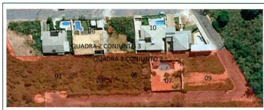
Figura 9 – Detalhe das Ocupações que interferem com APP – Parcelamento Recanto Real.
